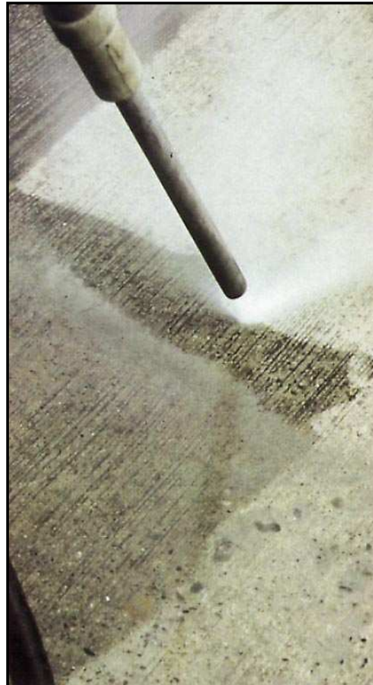
Мокрая пескоструйка (min. 900 bar)
