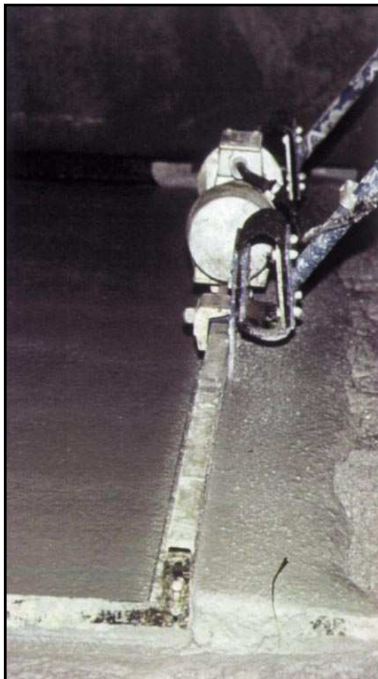
Укладка раствора виброрейкой
