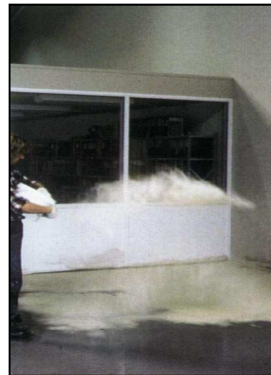
Покрытие песком или Парафиновой жидкостью Densit Curing Compound
