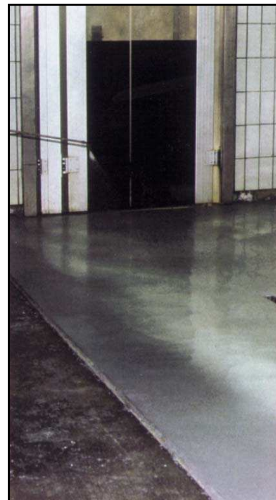
Покрытие песком или Парафиновой жидкостью Densit Curing Compound
