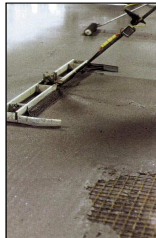
Разравнивание раствора виброрейкой
