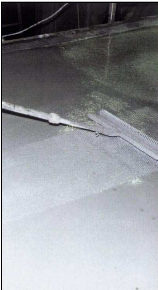
Разравнивание игольчатым роликом
