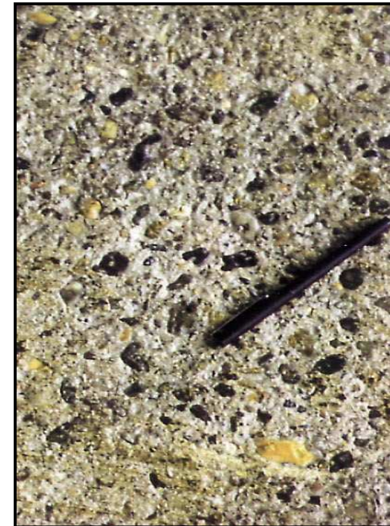
Поверхность должна иметь 2мм шершавой поверхности
