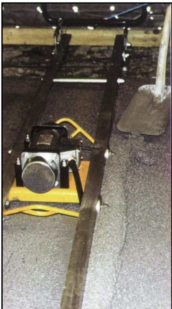
Укладка раствора виброрейкой
